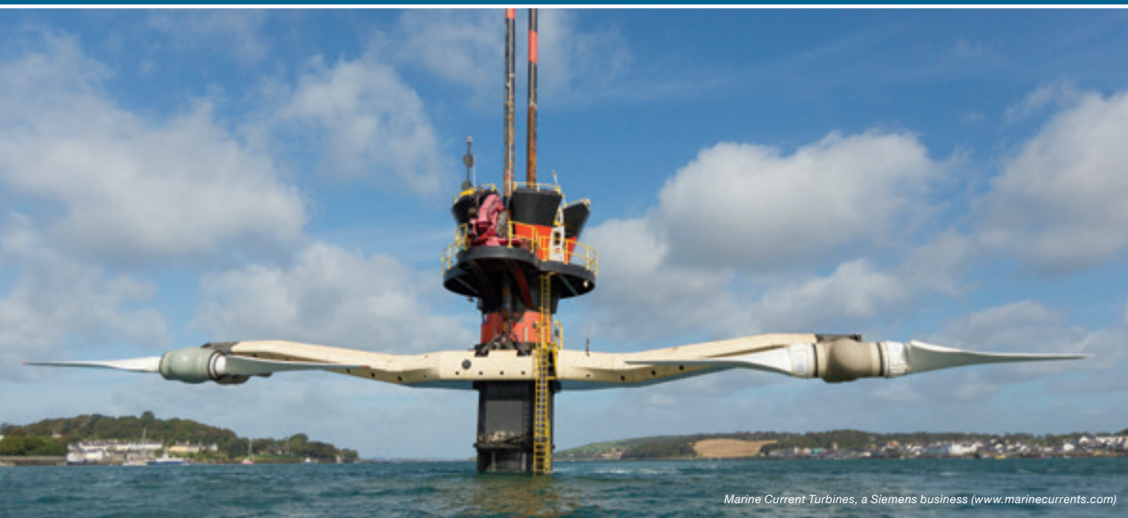
Nedan: Tidvattenströmkraftverket SeaGen från det brittiska utvecklingsbolaget Marine Current Turbines som ägs av Siemens.
